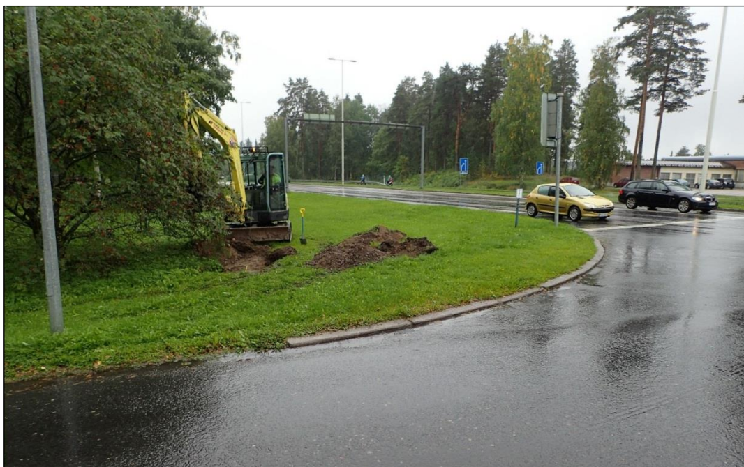
Kuva: Koeojan 4 sijainti (kaivinkoneen etupuolella). Takana Tainionkoskentieä, edessä Kotipolun reunaan tulevan kiertoliittymän kohdalla. Koillisesta.
